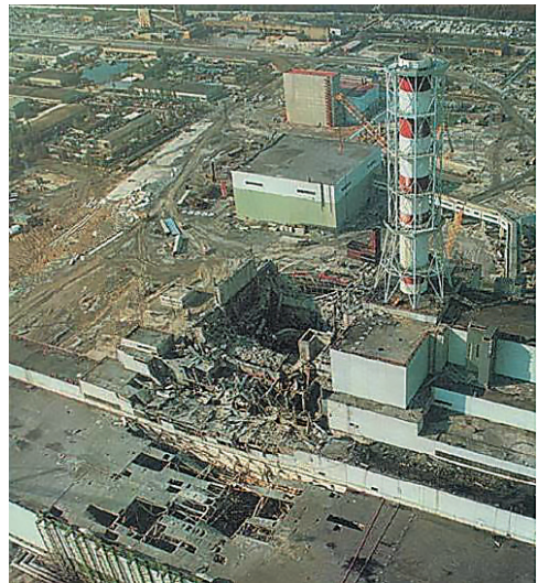
Зруйнований реактор на Чорнобильській АЕС
