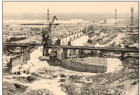
Будівництво Каховської ГЕС. 1953 р.
